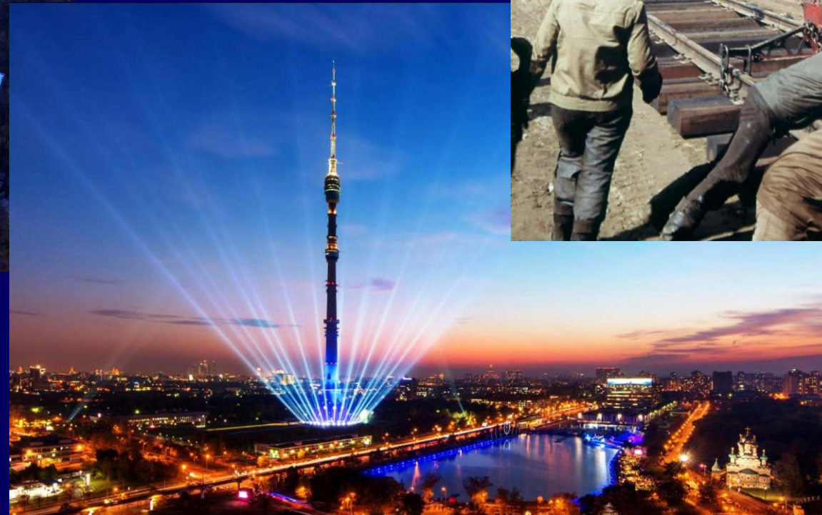
Останкинская телебашня, 1960-1963 - годы строительства, 1961- 1963 - приостановлено
